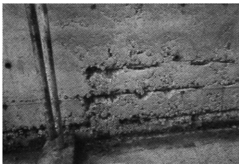
Figure 4 – Armatures mal enrobées lors du coulage du béton (le ragréage n'est qu'un mauvais remède)
