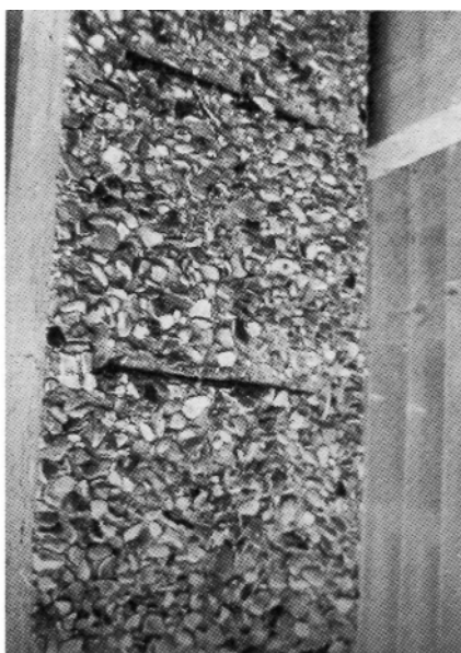
Figure 4 – Armatures mal enrobées lors du coulage du béton (le ragréage n'est qu'un mauvais remède)
